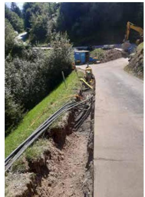
Die Grabungsarbeiten für die anschließende Kabelverlegung musste teilweise in sehr schwer zugänglichem Gelände durchgeführt werden.
